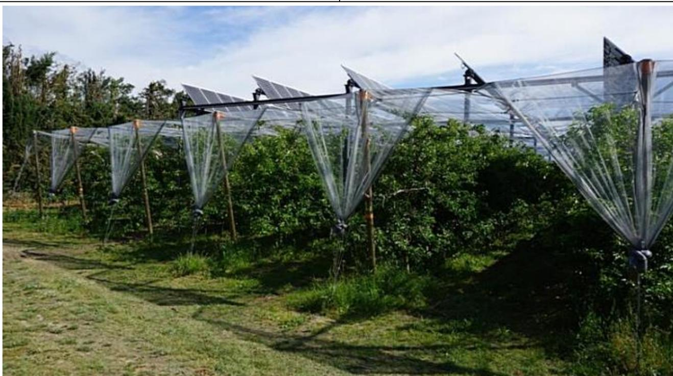
L'installation de panneaux solaires photovoltaïques réduit l'exposition du verger aux risques climatiques (gelées, grêle, sur-insolation...) et limite l'irrigation.
